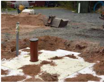
Eristä kaivanto ja viemäriputki routaeristelevyllä.
