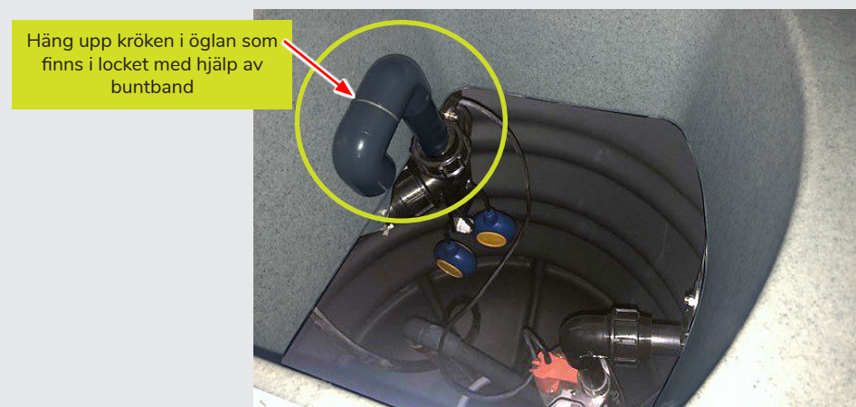
Bild 6: Montering av S-krök
