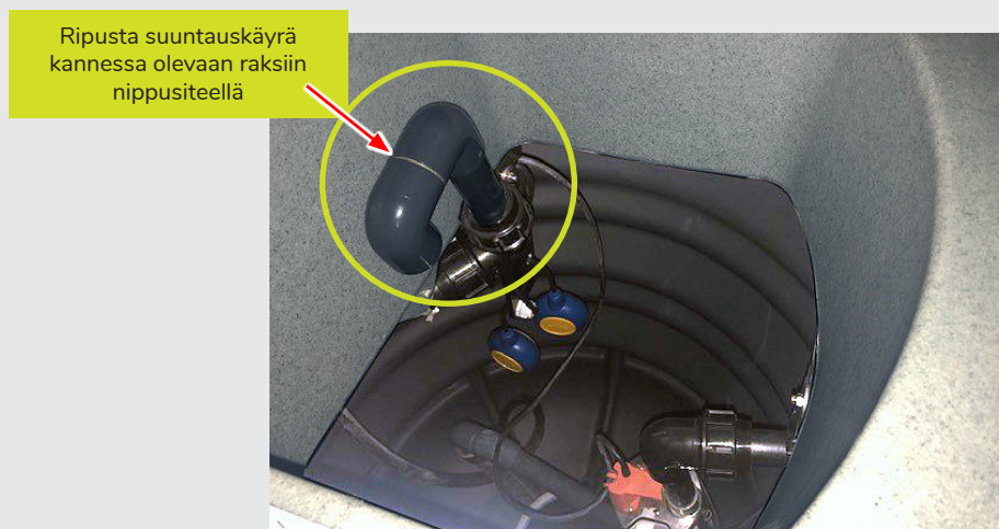
Kuva 7: S-käyrän asennus
