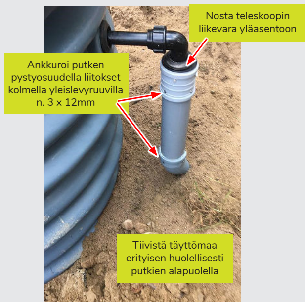
Kuva 20: Puhdistetun veden viemäriputken kytkentä
